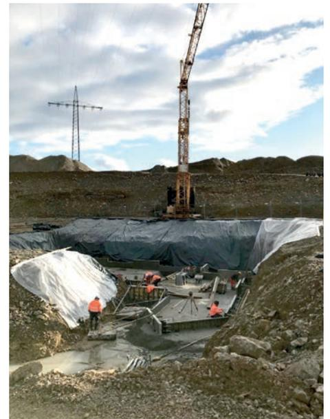
Die Baumaßnahme umfasst den Bau eines Regenklärbeckens in Minseln, direkt neben der dort entstehenden Erweiterung der A98. Teil der Baumaßnahme sind der Bau eines Fangbeckens, eines Durchlaufbeckens, eines Regenrückhaltebeckens und eines Retentionsbodenfilters. Zudem werden Kabellehrrohre, sowie eine Abwasserdruckleitung verlegt.
