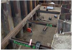
Im Zusammenhang mit dem Bau des gesamten Einlaufbauwerks musste zuerst eine Hafen- und binnenseitige Sohl- und Böschungssicherung hergestellt werden (Spundwandkasten mit 2 Querschotts (1. Querschott im Bereich Dammkrone, 2. im Rohrgraben) als bauzeitlichen Hochwasser-schutz und Flügelwände als Sickersperren).
