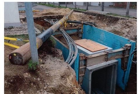
Unterquerung der Bundesstrasse B 34 mittels Betonrechteckkanal mit der Dimension B/H aussen 1,70/2,35 m in eine Verlegetiefe bis 4,85 m. Herstellung in z.T. Verbauten Gräben. Leerrohrverlegung ca. 1500 m DN 150. Wiederherstellung der Bundesstrasse.
