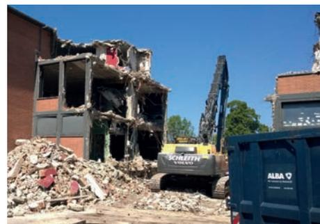
Beim ehemaligen Schwimmstadion in Heidelberg handelte es sich um ein 4-geschossiges Gebäude, welches zuletzt als Veranstaltungsstätte genutzt wurde. Die Entkernung und Schadstoffsanierung war geprägt von erheblichen Holz- und Gipsmassen, aber auch einer Reihe von Asbestprodukten. Hier war der Ausbau von Asbestzementplatten bis hin zum Ausbau von schwach gebundenem Asbest unter Einrichtung eines kompletten Schwarzbereiches notwendig.
