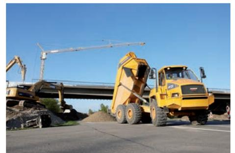
Nach der Fertigstellung der neuen Zweifeldbrücke war der Folgeauftrag für Schleith der Rückbau der alten Brücke über die A5, die parallel zur neuen noch stand. Dieser wurde Anfang April 2011 dann unter Vollsperrung innerhalb kürzester Zeit vollzogen.
