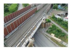
NEUBAU SCHALLSCHUTZWAND EIMEL-DINGEN WEST BAHN-KM 257,8+00 BIS 251,1+74
