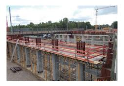
Durch den Ausbau der BAB A5 muss an Stelle der vorhandenen Brücke ein neues Überführungsbau-werk (4-Feld-Brücke) für B26 und Straßenbahn errichtet werden. Damit verlängert sich das Brückenbauwerk um ca. 35 m westlich (in Richtung Griesheim) und um ca. 25 m östlich (in Richtung Darmstadt).
